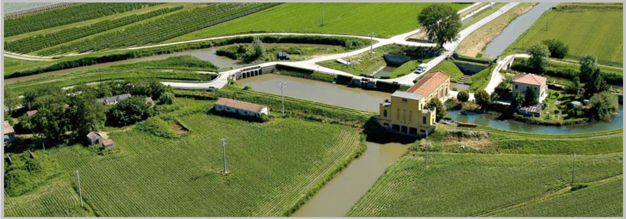
Idrovora Busiola (S. Anna); a destra il canale derivatore dall'Adige, a sinistra il bacino di scarico verso l'emissaria Busiola, in alto e in basso i canali di bonifica
