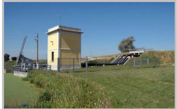
Idrovora Cuora con scarico in Canale di Valle (Rosolina)
