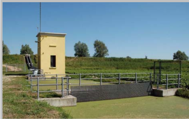
Idrovora Gottolo con scarico in Adige (Rosolina)
