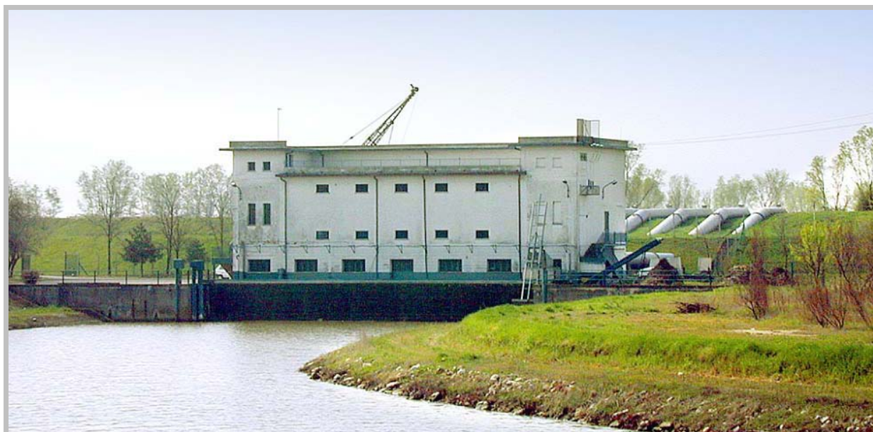
fig.5 – Impianto idrovoro Goro (Isola di Ariano) in funzione dal 1977
